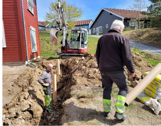
Dugnad: Fundamentering av stolpene til eplegjerdet.
