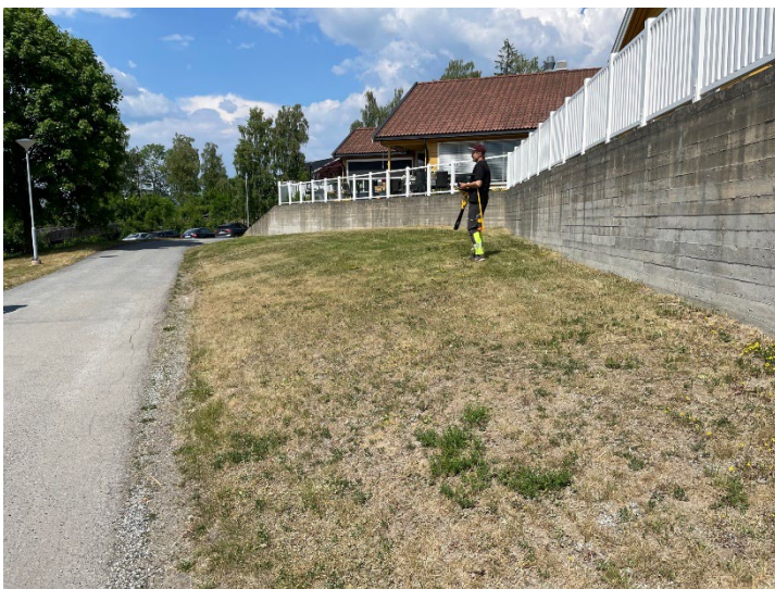
Geomatikk gjør kabelpåvisning.
