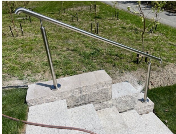
Håndløper for støtte.
